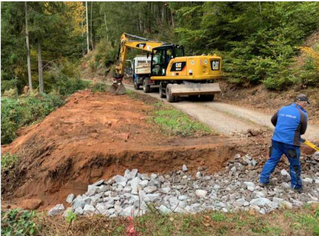
Abbildung 12: Verdichten der Rigole mittels Rüttelplatte und verteilen des Aushubes auf der Bankette
