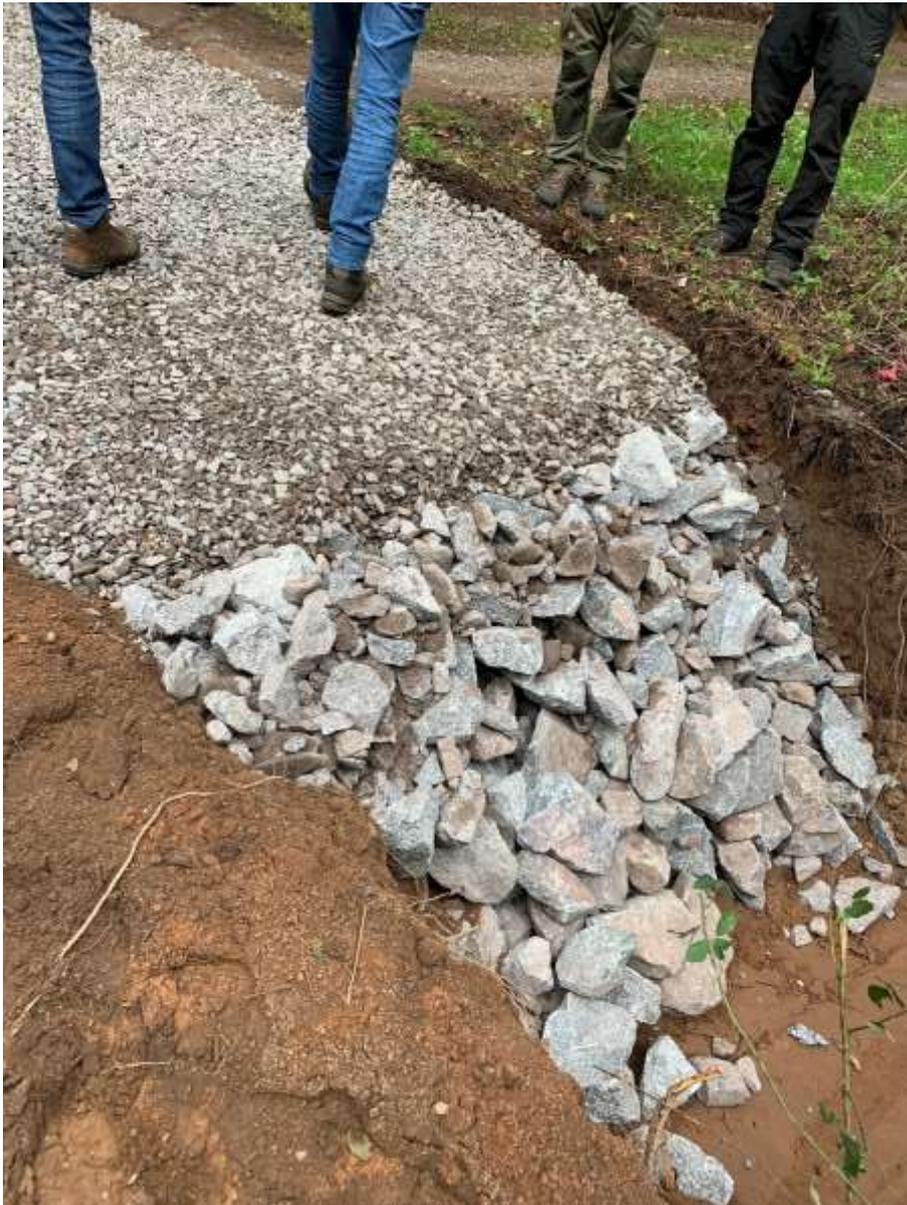
Abbildung 13: Fertig mit Feinmaterial abgedeckte Rigole
