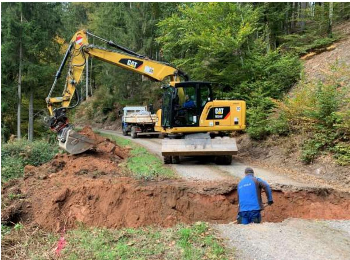
Abbildung 10: Ausheben des notwendigen Volumens für die Rigole
