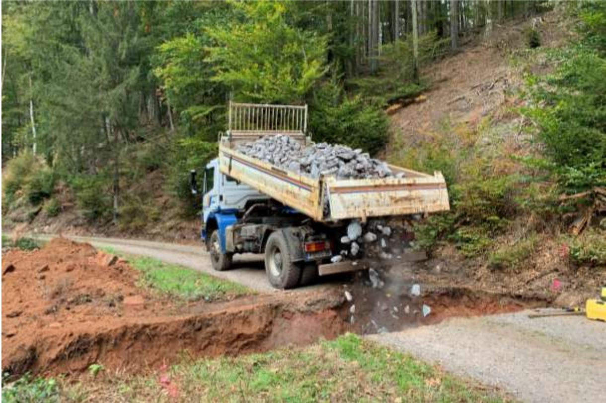
Abbildung 11: Befüllen der Rigole mit groben Steinen
